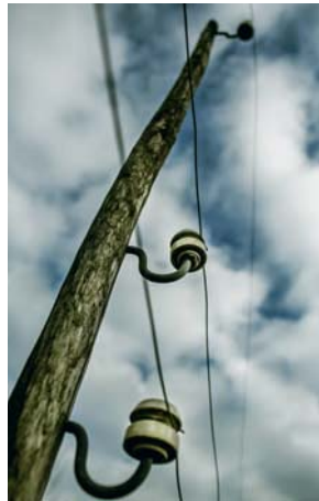
'Elektriek, dat kenden we toen helemaal niet. Boeren hadden thuis alleen een petroleumlamp.'
